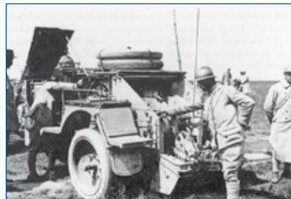
Treuil Caquot à deux moteurs Panhard sur tracteur Latil à quatre roues motrices (J. Kerisel, *Albert Caquot, savant, soldat et bâtisseur*, ENPS, p. 46).
